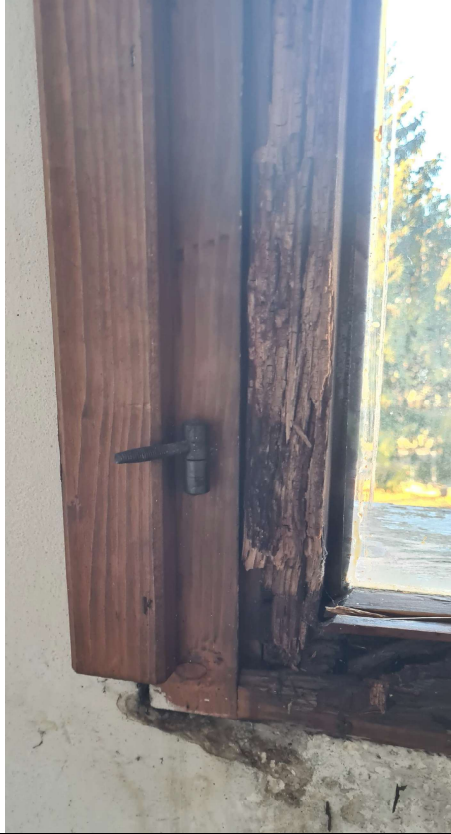
Telaio finestra del castello
