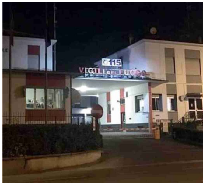
Il comando provinciale dei vigili del fuoco di via della Canalina
