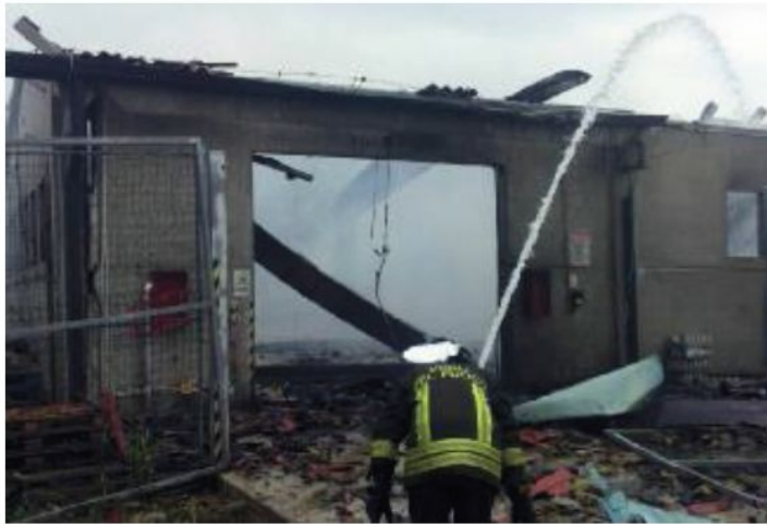
L'intervento dei vigili del fuoco nel deposito distrutto
