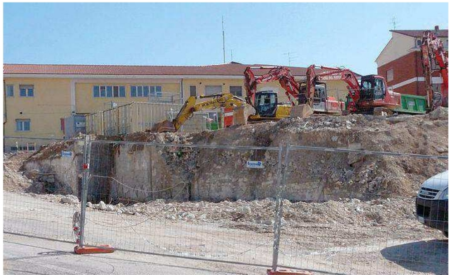
Ruspe al lavoro per procedere all'abbattimento di una parte della vecchia sede della caserma dei vigili del fuoco
