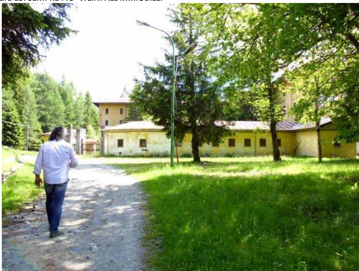
Figura 14: SI INIZIA A VEDERE MEGLIO LO STABILE ONA.
