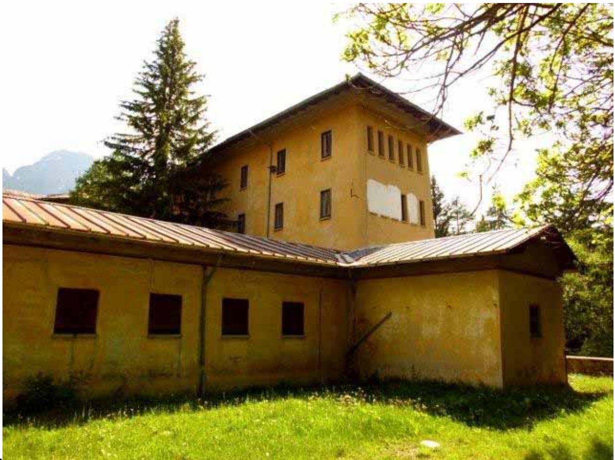
Figura 31: VISTA DELL'IMMOBILE ONA DAL LATO PIAZZALE.
