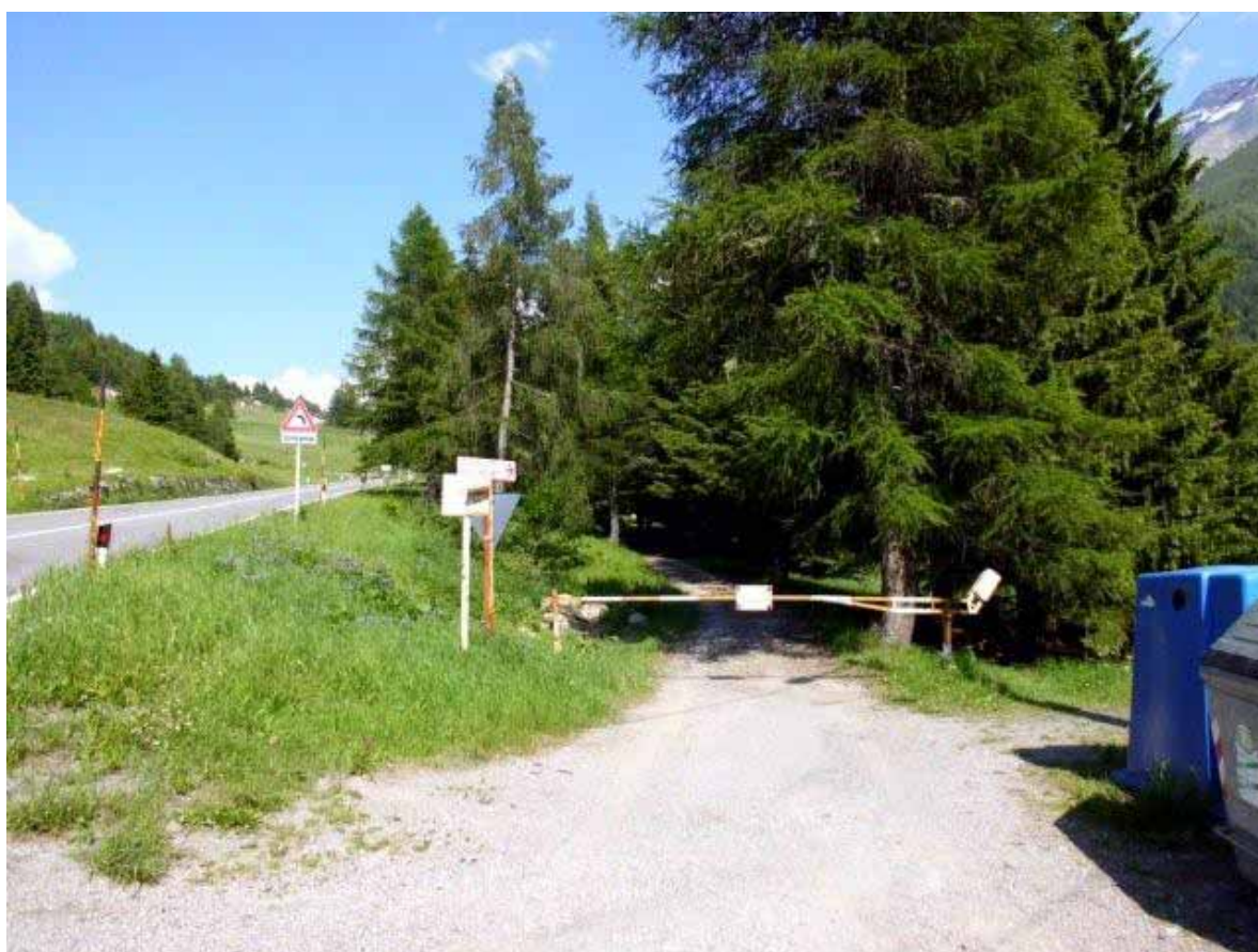
Figura 8: LA SBARRA D'INGRESSO DELLA STRADA CHE CONDUCE AL "CENTRO DI SOGGIORNO DEL TONALE" DELL'ONA – STRADA STATALE DEL PASSO DEL TONALE.
