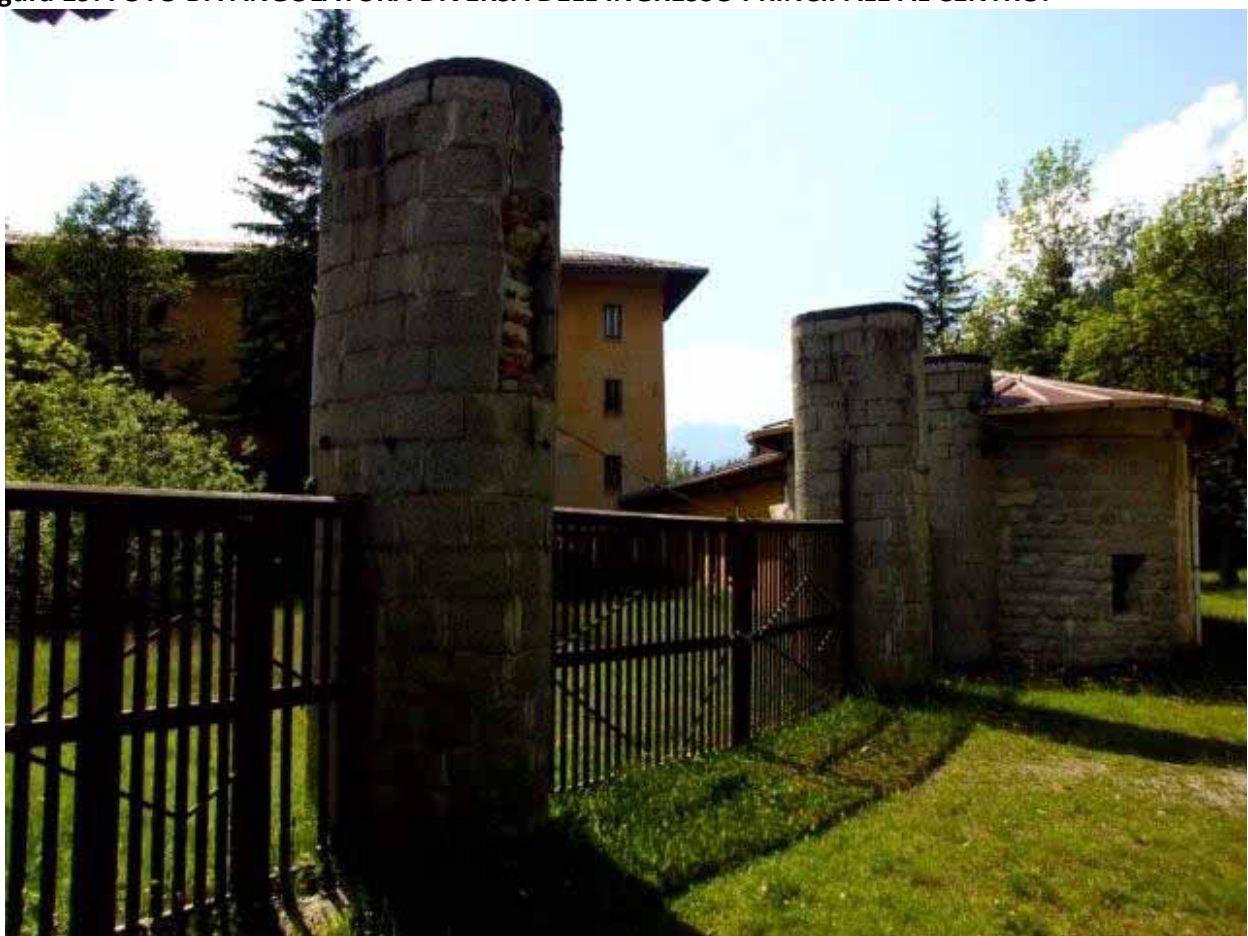
Figura 20: INGRESSO AL CENTRO – ALTRA ANGOLATURA.
