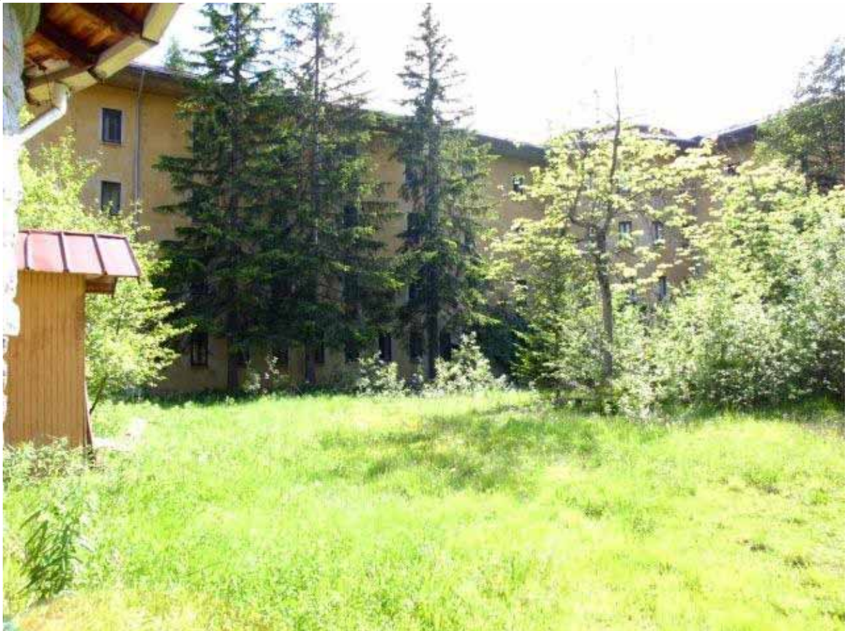
Figura 26: SCORCIO DELL'ENTRATA E DEL GIARDINO VISTI DAL CANCELLO D'INGRESSO LATO SINISTRO.
