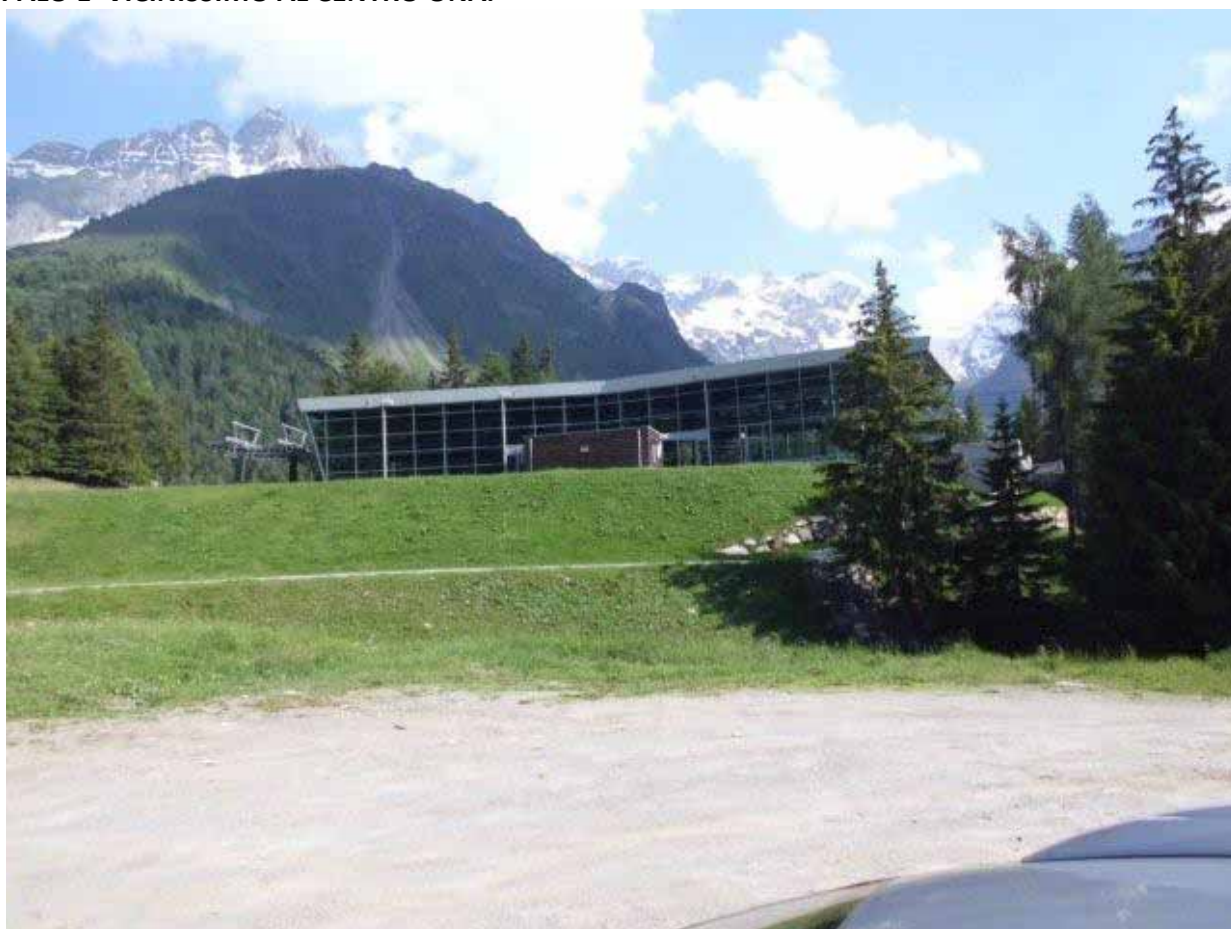
Figura 43: LA STAZIONE “VIGILI DEL FUOCO” DELLA FUNIVIA PONTE DI LEGNO / TONALE AD OGGI PERFETTAMENTE FUNZIONANTE.
